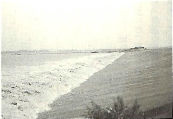
8月2日夕刻 溢流堤をこえて水が流作方向に流れ込む
